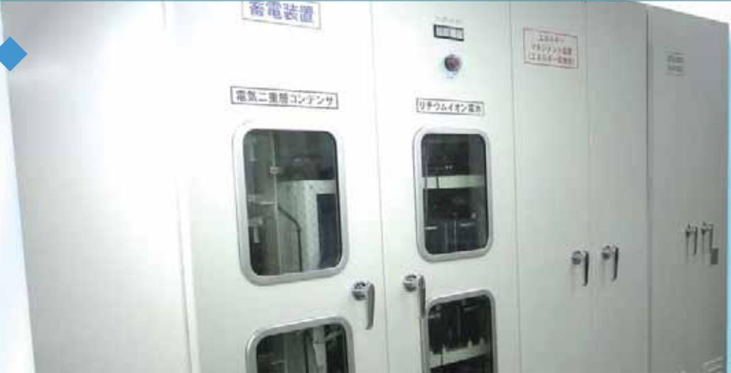
電力の自給自足を行うための装置がこの電力管理システムです。太陽光発電からの増えたり、減ったりする電気を蓄えることで館内に安定した電力を供給しています。
